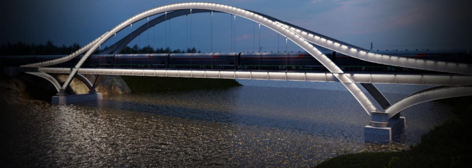
Современные осветительные технологии помогут организовать ресурсосберегающее освещение на железнодорожных мостах. Использование светодиодных светильников с повышенной устойчивостью к ударно-вibrationным нагрузкам существенно снижает эксплуатационные затраты на регулярный ремонт и замену вышедших из строя приборов.
